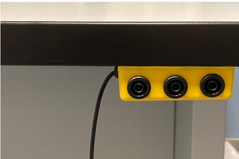
Il nodo di terra applicato sotto il piano di lavoro mediante due viti autofilettanti fornite in dotazione
